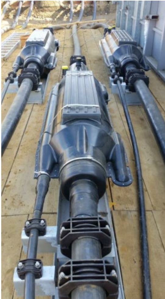
Abb. 3-3: Beispiel für eine Muffenverbindung
